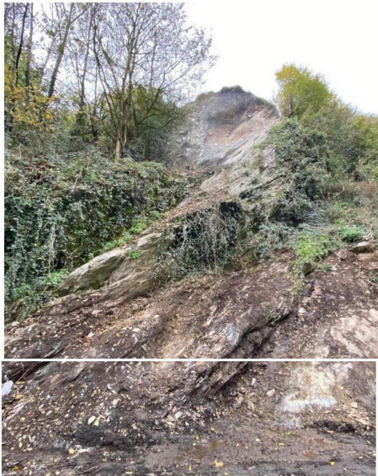
La pose de filets métalliques doit permettre d'éviter que des pierres se détachent de la paroi. J.L.
